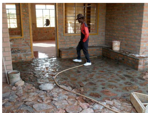
Die Steine auf der Veranda werden verfugt. Entlang der Hausmauer sind Sitzgelegenheiten für die Kinder gemauert. Fenster- und Türeinfassungen sind frisch gestrichen.
