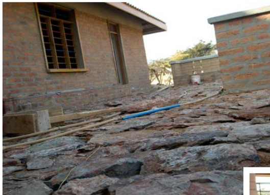
Steine werden auf der Veranda verlegt.
