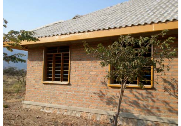
Blende und Fensterumrahmungen sind frisch gestrichen.
