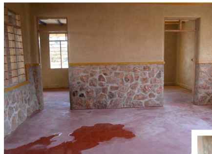
Blick ins Wohnzimmer und zwei anschließende Schlafzimmer. Die Wand ist mit Naturstein verkleidet (Schutz gegen Verschmutzung). Der Fußboden ist gegossen und wird noch gewässert.
