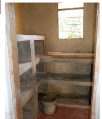
Regale im Vorratsraum, aus Beton gegossen.
