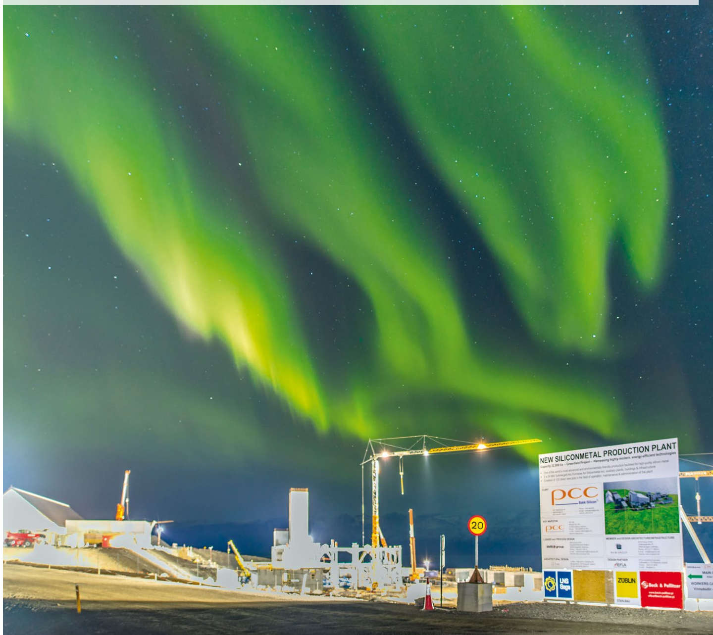
Nordlichter über unserer Großbaustelle bei Húsavík im Norden Islands. Die PCC BakkiSilicon hf baut hier bis 2018 eine der weltweit modernsten und auch umweltfreundlichsten Siliziummetall-Anlagen, links im Bild die bereits fertiggestellte Kohlelagerhalle (siehe auch Seite 4).
