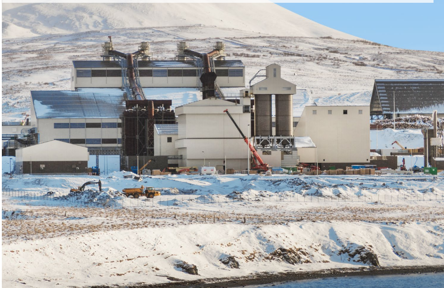
Widok placu budowy firmy PCC BakkiSilicon hf na północy Islandii w lutym 2018 roku: W środku zdjęcia, w tle widać piecownię, która mieści dwa piece lukowe. Uruchomienie wytwórni przewidywane jest na przełomie marca i kwietnia.
