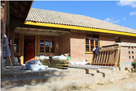
Das gelbe Haus während der Renovierungsarbeiten
