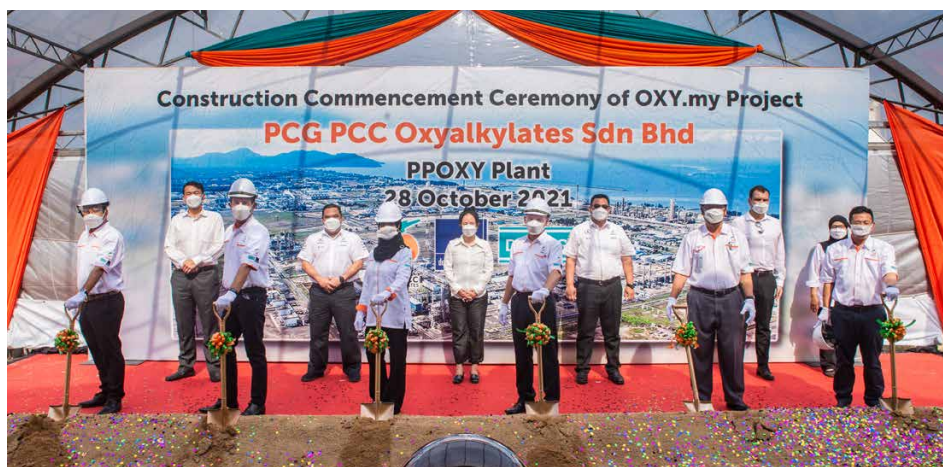
Inauguracja budowy instalacji alkoksylatów „Oxy.my” firmy PCG PCC Oxyalkylates Sdn. Bhd., spółki joint venture z PETRONAS Chemicals Group Berhad, w Malezji: Ceremonia wmurowania kamienia węgielnego odbyła się 28 października 2021 roku, a oddanie instalacji do użytku planowane jest na trzeci kwartał 2023 roku.
