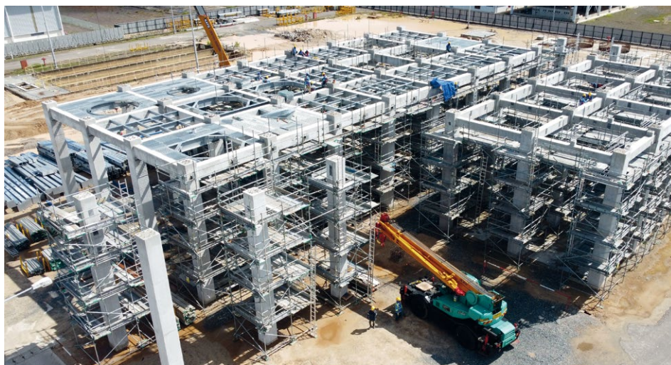
W Malezji budujemy wytwórnię alkoksylatów w ramach spółki joint venture z PETRONAS Chemicals Group Berhad. Prace budowlane przebiegają zgodnie z planem. Zdjęcie przedstawia plac budowy w marcu 2022 roku.
