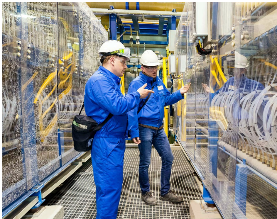
Membranelektrolyse-Anlage der Business-Unit Chlor der PCC Rokita SA an unserem polnischen Produktionsstandort Brzeg Dolny: Schon früh, 2015, haben wir unsere Chlor-Produktion komplett auf die heute in der EU verbindliche, umweltschonende und energiesparende Membrantechnologie umgestellt.
