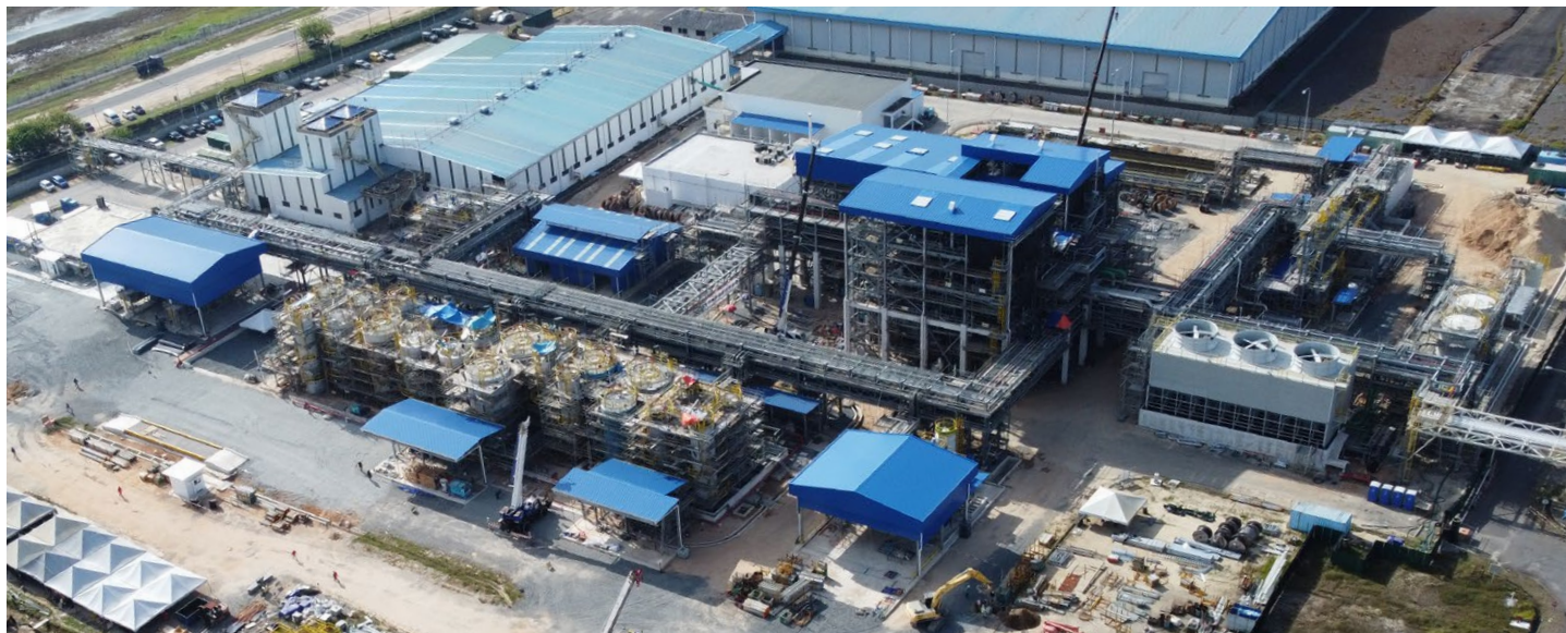
Budowa wytwórni alkoksylatów w Malezji, którą Grupa PCC realizuje w ramach spółki joint-venture z PETRONAS Chemicals Group, była w pierwszym kwartale 2023 roku kontynuowana. Uruchomienie wytwórni, której roczne zdolności produkcyjne wynoszą 70 tys. ton, jest niezmiennie planowane na trzeci kwartał 2023 roku.
