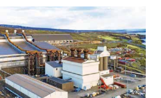
Im Siliziummetallwerk in Island produziert PCC seit 2018 mit Tiefgeothermie Siliziummetall. PCC
